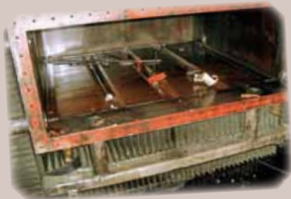
Transformateur vandalisé
